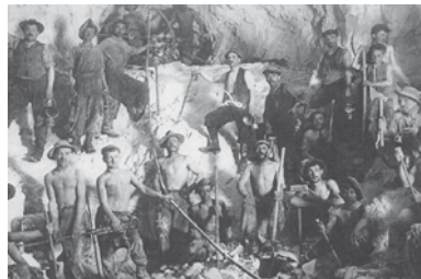
Les mineurs dans le tunnel du Lötschberg vers 1911.
