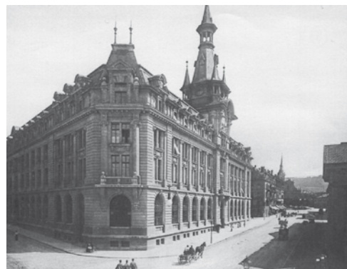
Image pour le mois de février: L'imposant bâtiment de la poste du Bollwerk achevé en 1905.
