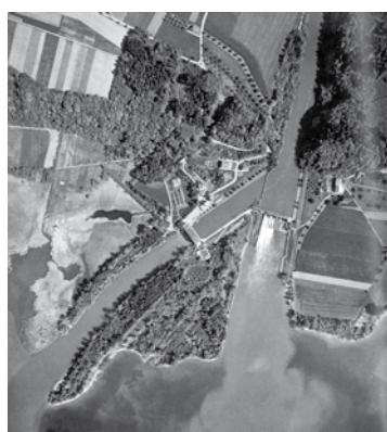
L'embouchure de l'Aar dans le lac de Bienna à Hagneck en mai 1961: à gauche l'usine hydroélectrique et à droite le barrage.
