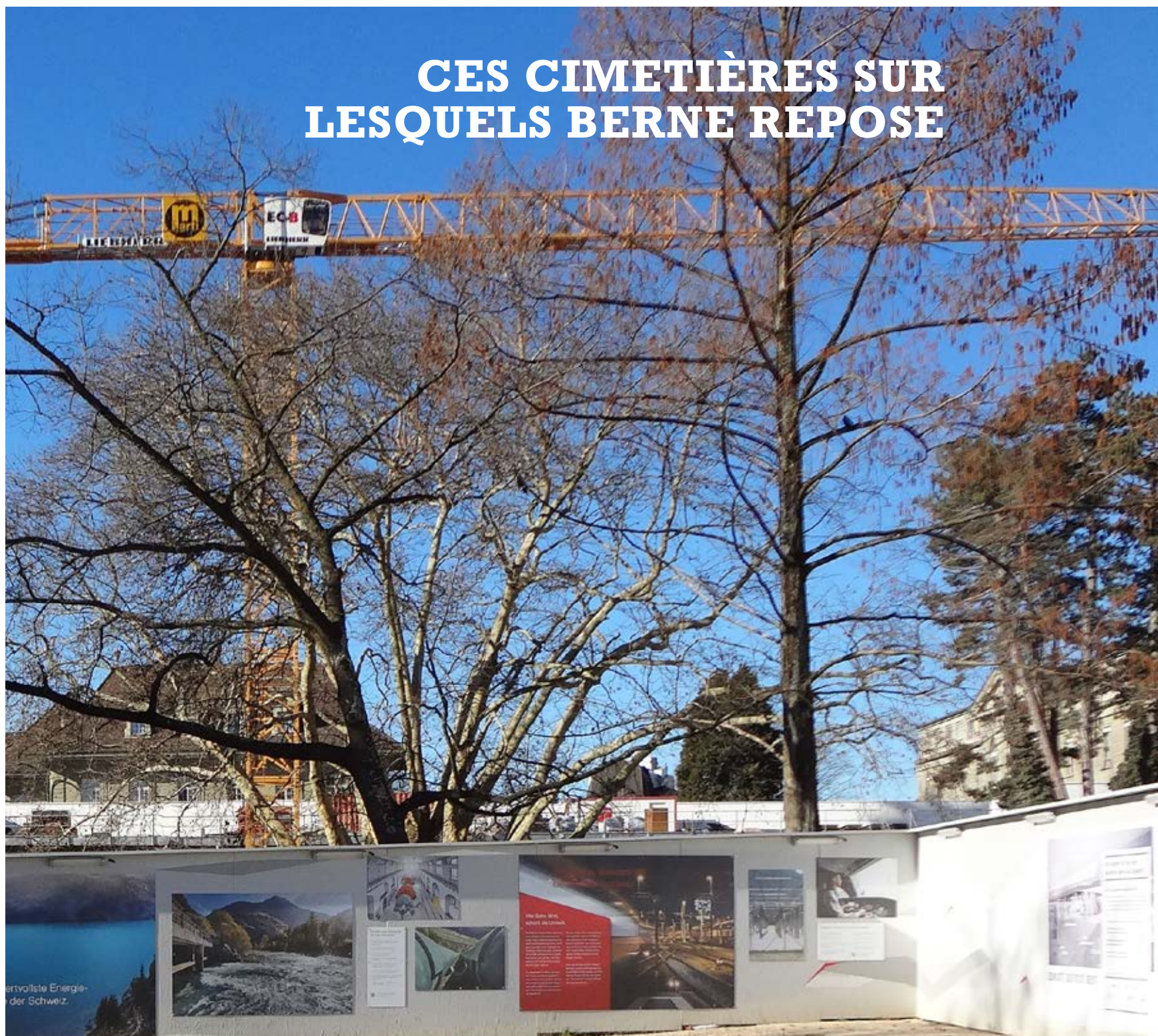
Le chantier de la Grosse Schanze (photo Christine Werlé)
