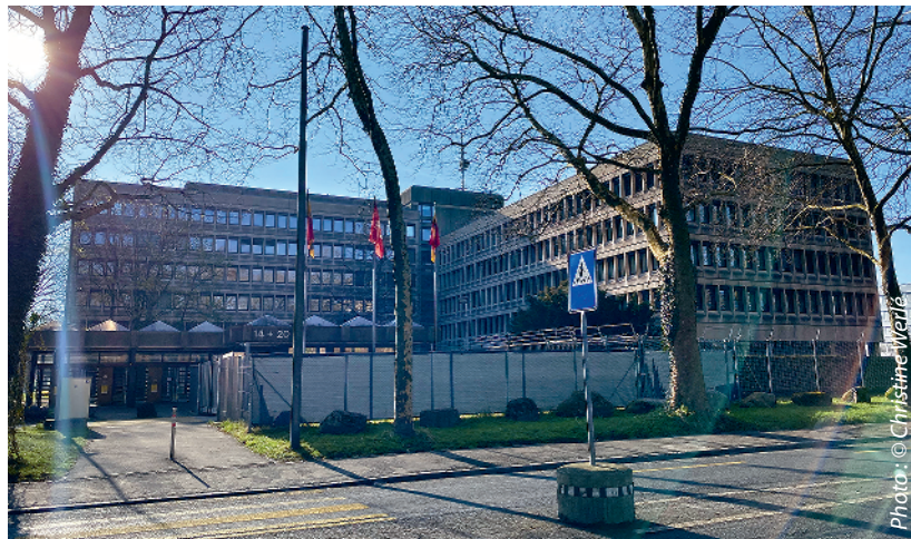
Le Service de renseignement de la Confédération (SRC), à deux pas du Wankdorf
