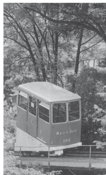
Le funiculaire du Marzili d'une longueur de 105 m avec différence de niveau de 32 m transporte un million de voyageurs par an. Photo Christoph Hurni
