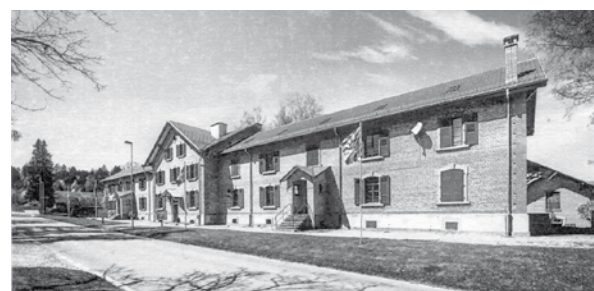
Le bâtiment de commandement du site de Schönbühl-Sand fait partie du groupe des bâtiments édifiés entre 1900 et 1904. Photo: Yves Bachmann.
